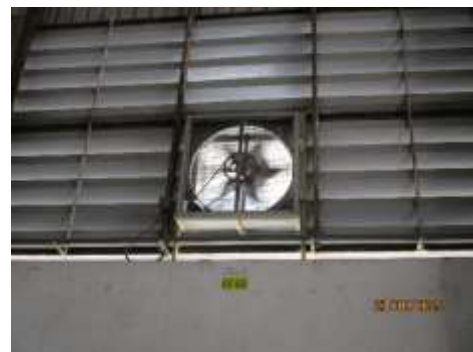
ภาพที่ 2-29 พัดลมระบายอากาศ
