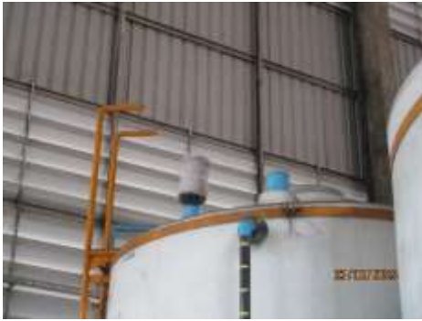
ภาพที่ 2-6 ระบบดูดซับไอระเหยถ่านกัมมันต์ (Activated Carbon Filter)
